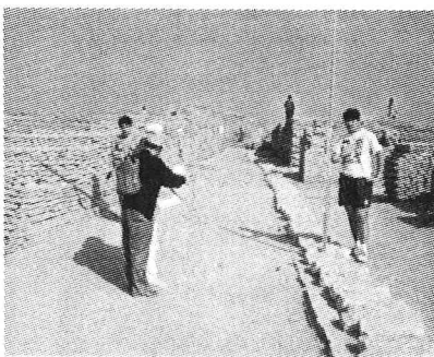
写真2 これを測量しているところ
