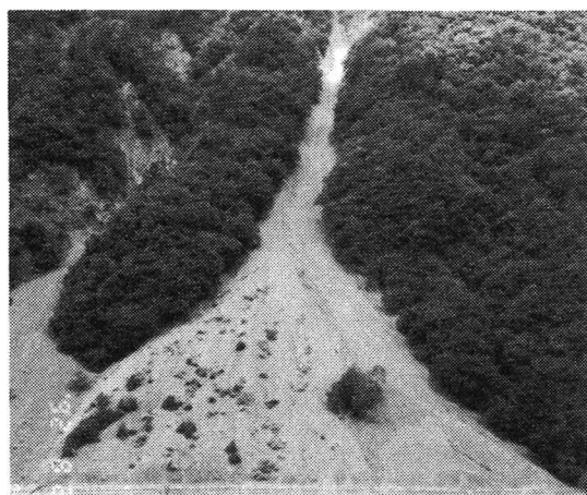
写真-1 崩壊性流域における河道への土砂流入
