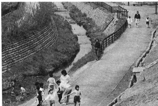
写真5. 梅田川。低水路の現状
