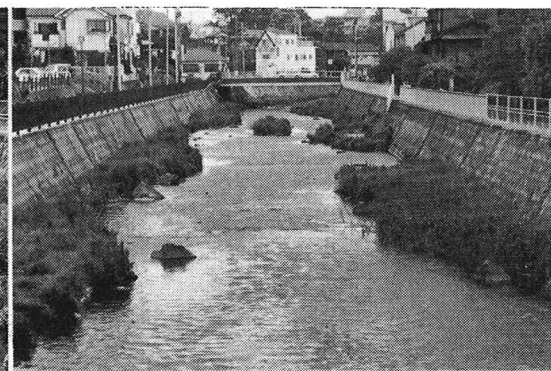
写真4. 低水路の現状（蛇行低水路）
