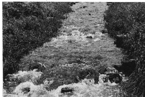
写真13. 斜路工部の流れの様子
