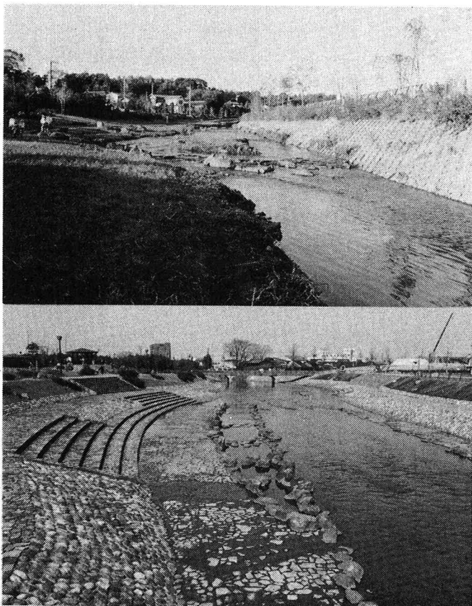
写真7 緩傾斜部での親水化工事における羽口構造の違い
