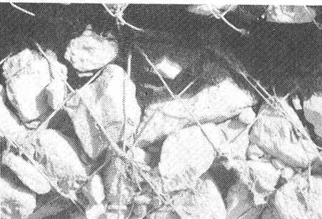
写真-2 新しく設置された蛇籠
