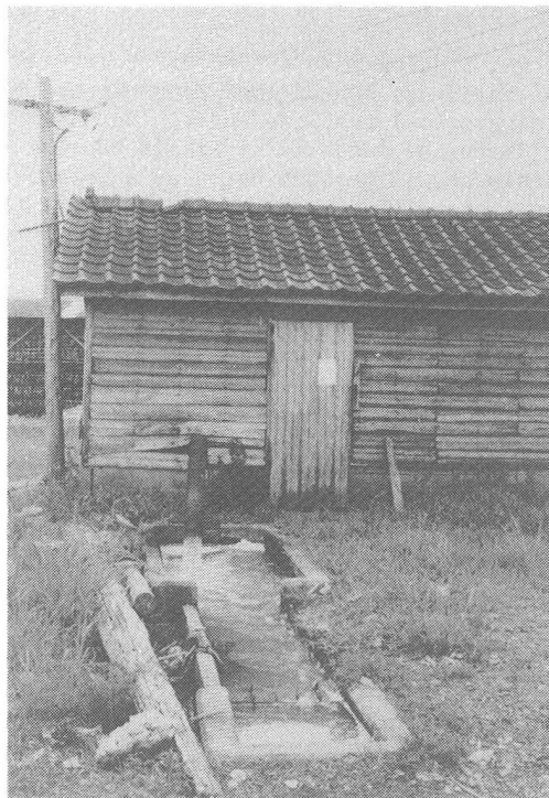
写真 深井戸による農業用水の揚水
