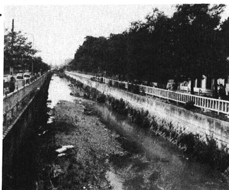
写真 土居川の現況(南東部上流)
