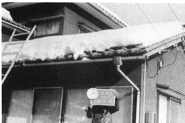
図4 屋根雪の状況 右から2枚目、3枚目および4枚目の瓦の上方に菱形ビニール網を用いた雪害防止ネットが敷設されている。
