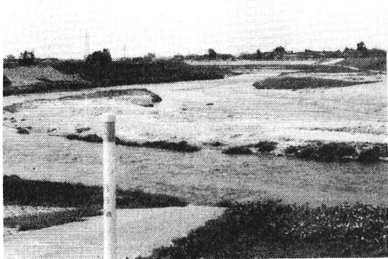
図一 佐々木町、わん曲部周辺（河口から約 8.6 km） （撮影：中川 昭和 59 年 5 月 11 日）
