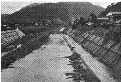
写真8. 御幸橋エ流，護岸はコンクリート化され 樹木による景観への配慮もなす施工。
