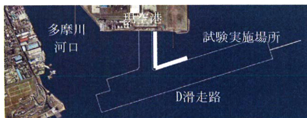
図－6 試験実施場所（東京国際空港沖のD滑走路工事区域内）
