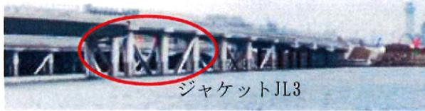
写真-3 北側場周導路（現空港側）
