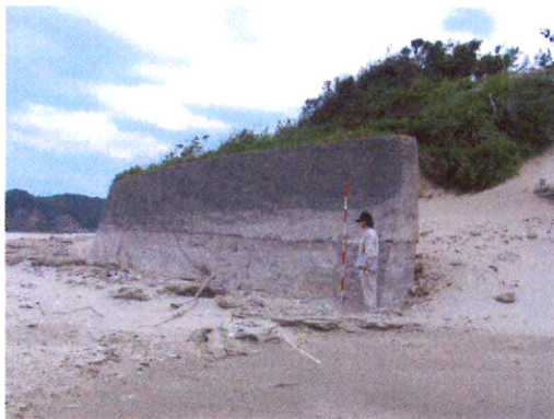
図-12 直立護岸の状況（2006年4月28日）
