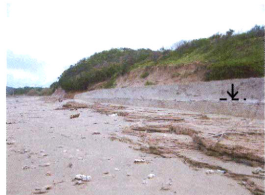
図-6 広田遺跡海側の直立護岸前面に露出したビーチロック（2005年9月6日）
