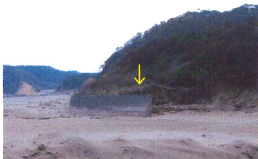
図-7 護岸北端部の西側直近での浜崖侵食 (2005年9月6日)
