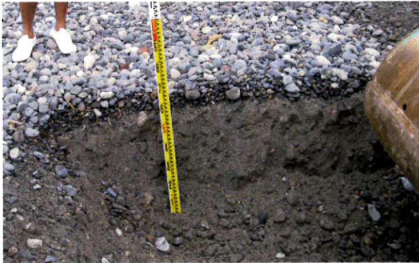
図-16 No. 7の前浜での掘削状況
