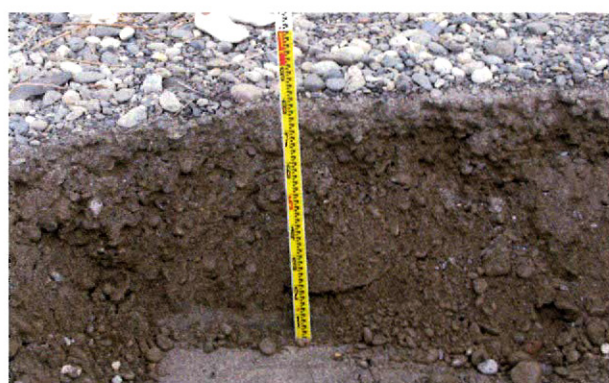
図-12 No. 4の盛土養浜前面での掘削状況
