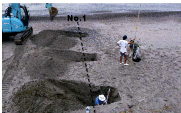
図-10 現地調査の状況 (No. 1)
