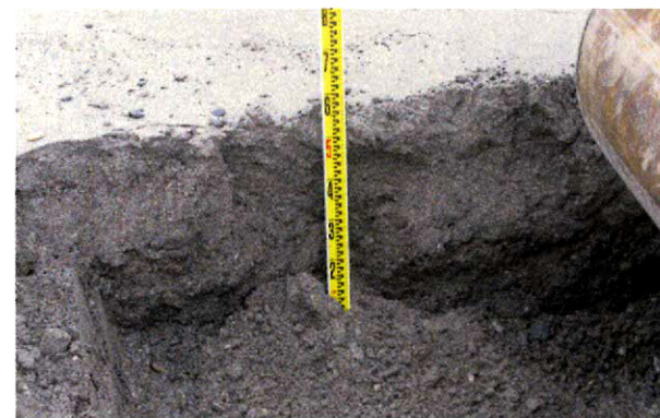
図-14 No. 4の汀線付近での掘削状況
