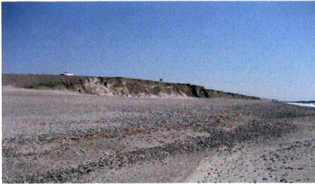
図-2 盛土形状の粗粒材養浜 (2009. 9. 16)
