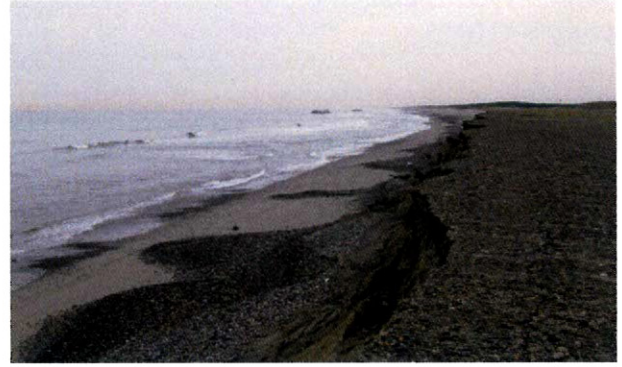
図-5 盛土養浜前面の海浜の状況 (2009. 9. 15)
