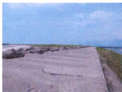
図-9 防波堤の隙間を抜けて運ばれた堆積した飛砂 (2009年8月19日撮影)
