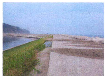
図-10 防波堤上の飛砂の作った模様と防波堤背後への堆砂 (2009年6月25日撮影)
