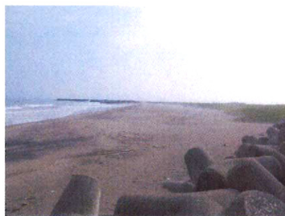
図-6 防波堤隅角部に形成された砂浜 (2009年6月25日撮影)
