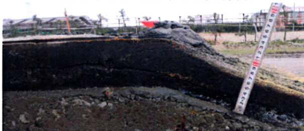
写真-8 法肩部の出来形
