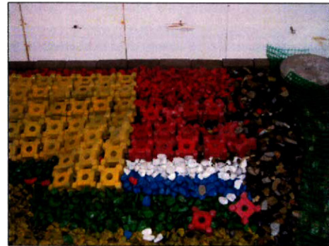
写真-2 背面マウンド（B区）の被覆ブロック被害状況
