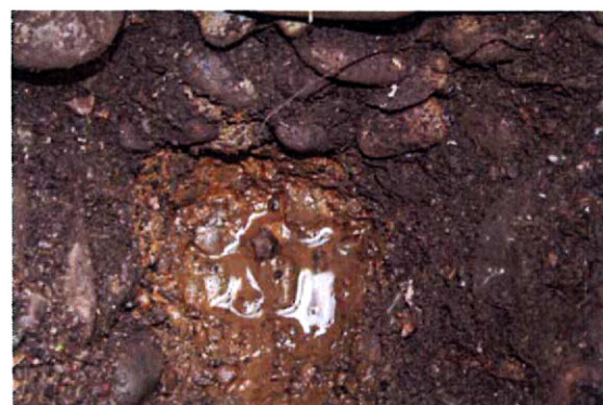
写真-7 内水面側の礫浜内部構造（湖水面水位付近の粘土層と上部の有機物層）
