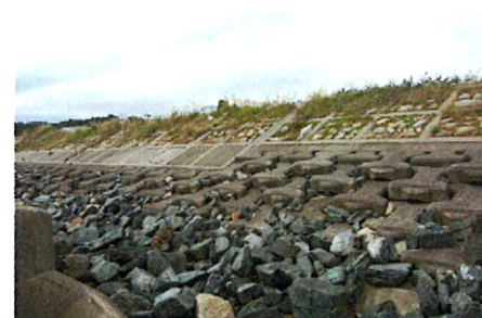
写真-3 複合断面護岸
