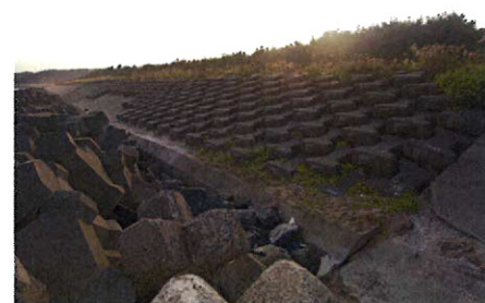
写真-2 ブロック被覆式傾斜護岸
