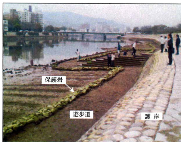
写真-4 旧太田川空鞘橋下流に施工された遊歩道（河岸に堆積したヘドロ干潟上に地盤改良材を用いて施工（太田川河川事務所施工））
