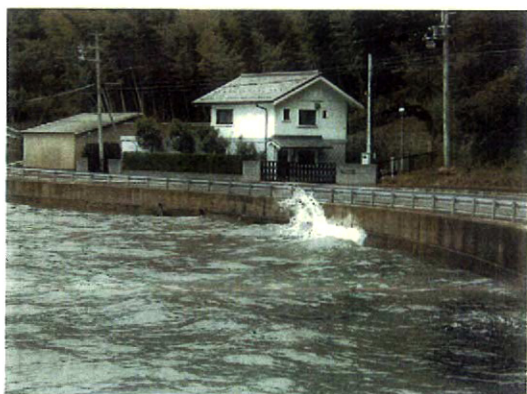
写真-2 道路護岸造成後
