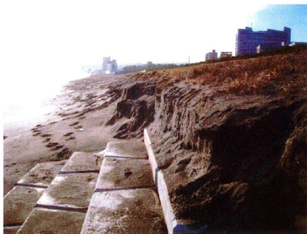
図-8 ポケットビーチ北東端近傍のX=450m付近における浜崖形成
