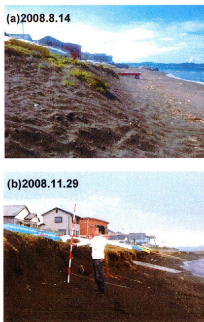
図-15 緩傾斜護岸の南端部での海岸状況の変化
