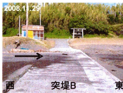
図-9 突堤B上での砂の堆積
