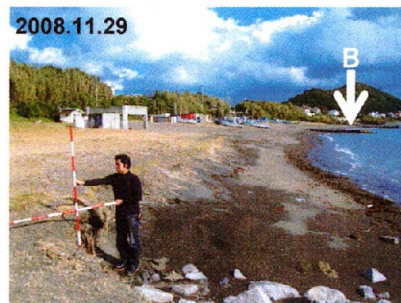
図-7 突堤Aの下手側に形成された浜崖
