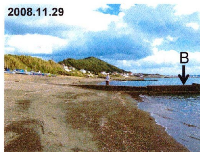
図-8 突堤Aの東約130mにある突堤Bの状況
