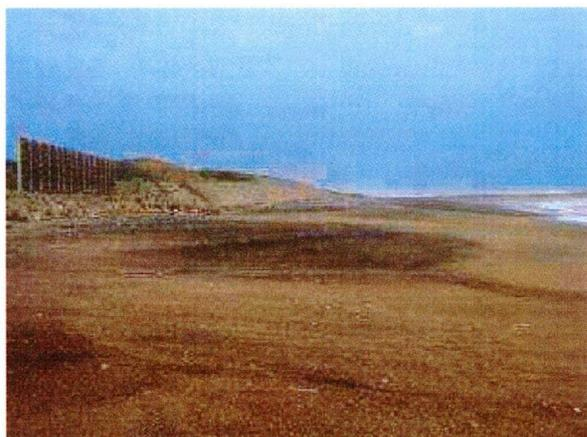
図-2 海浜表面に粗粒材が露出していた時期と細砂が堆積した時期における海浜状況の違い
