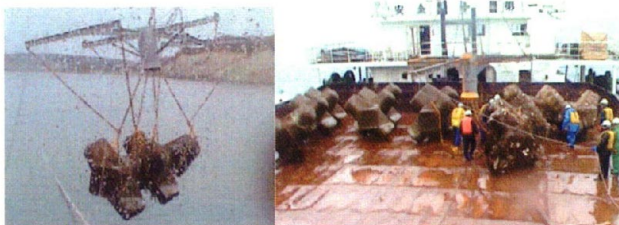
写真-7 10t-4m ブロック回収(左)及び解放(右)
