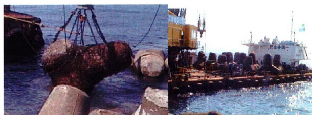
写真-9 吊り上げ(左)及び台船積み込み(右)
