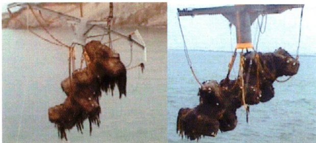
写真-6 12.5t-5m 長ブロック回収
