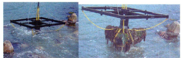
写真-4 作業開始後10秒(左)及び開始後50秒(右)
