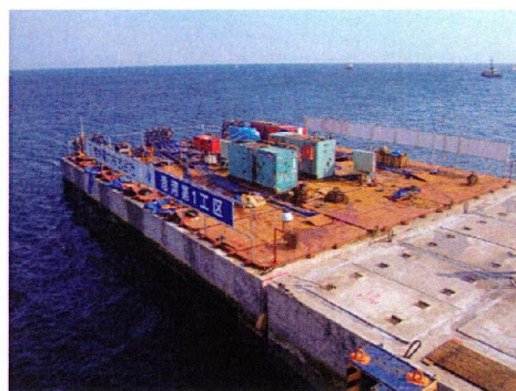
図-11.2 ケーソン据付状況（着底完了）
