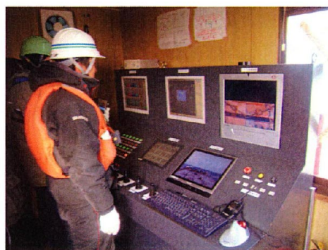
図-11.1 ケーソン据付状況（監視室での誘導状況）
