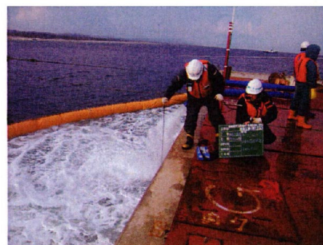
図-13 濁度監視状況
