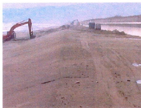
写真-2 南工区における養浜盛土の施工状況 (2007年3月17日撮影)
