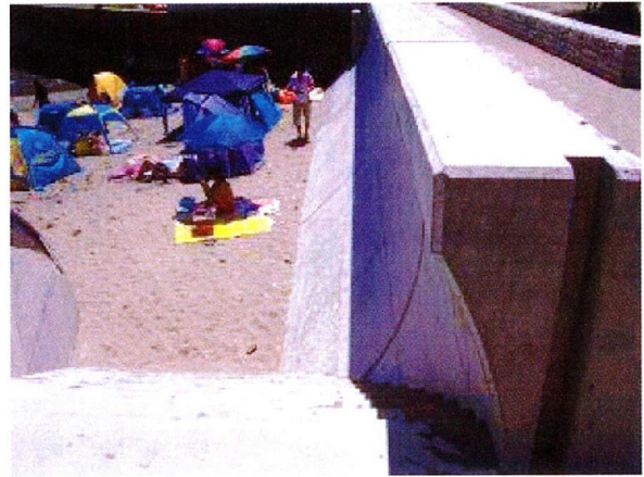
図-7 前面護岸と階段工（千倉海岸）
