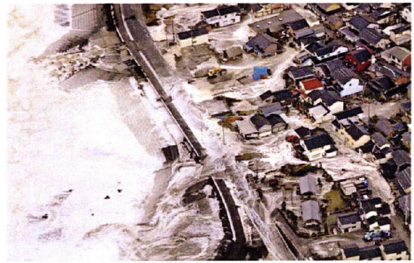
防波堤を越えて住宅に押し寄せる高波。富山県入善町で。読売新聞社提供
