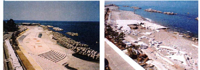
写真-2 入善漁港海岸（左下：被災前，右下：被災後）
