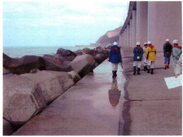
写真-1 親不知高架橋波浪対策護岸
