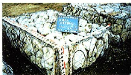
写真-1 簡易改良手法の検討に用いた石籠
