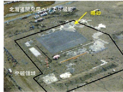
写真-1 発破後の様子
