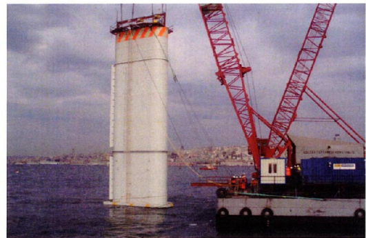
写真-1 AS沈設状況
