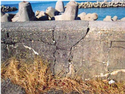
図-1 老朽化した海岸保全施設の事例
