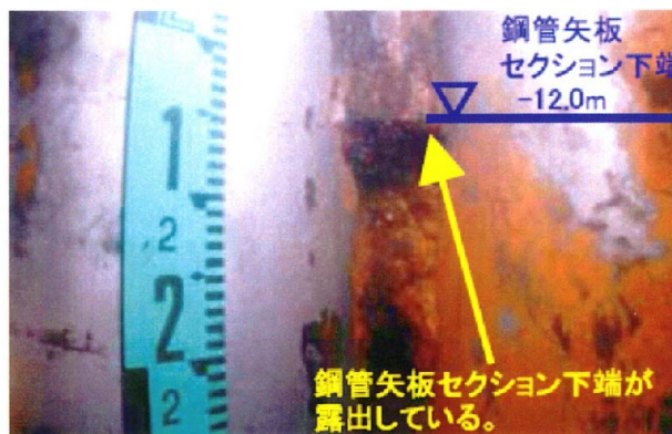
写真-6 鋼管矢板のセクション下端露出状況
