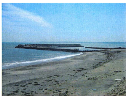
図-16 本港防波堤の全景（2007年11月23日）
