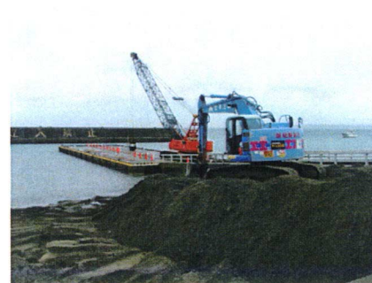
図-12 本港内における堆積土砂の浚渫状況 (X=3.4km: 図-1 の③)
