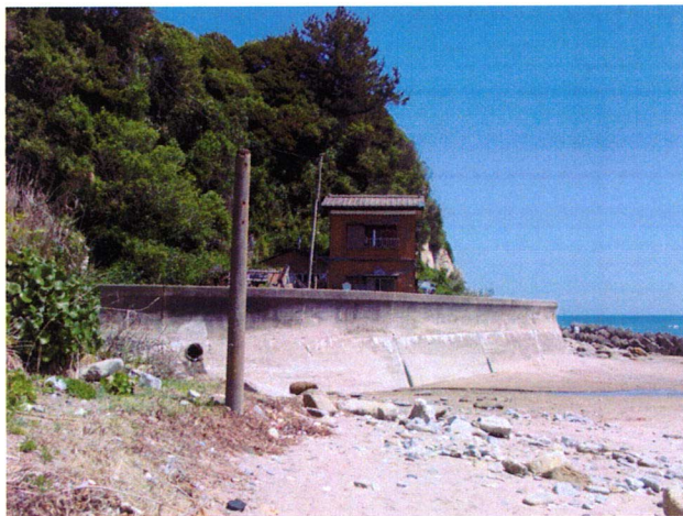
図-15 孤立家屋への送電のための電柱
