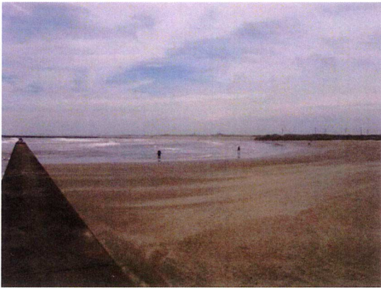
図-16 片貝漁港での著しい堆砂状況 (X=1.8km)
