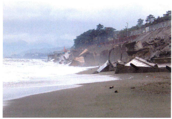
図-4 西湘バイパス被災区間を東側から望む (10月8日撮影)
