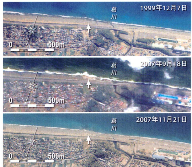
図-10 葛川河口周辺の空中写真
