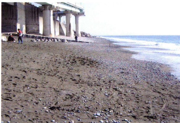
図-9 銀波橋直下の海浜状況（2006年12月1日撮影）
