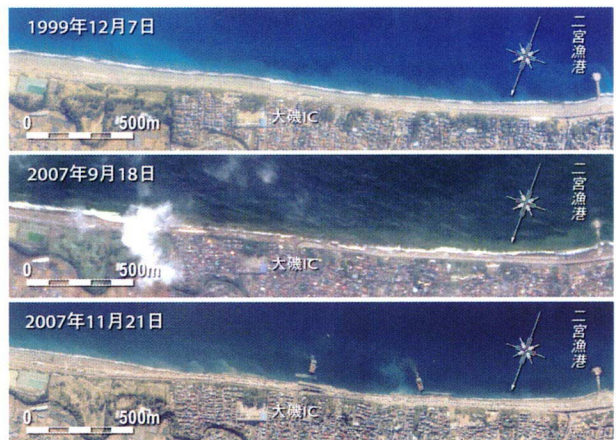
図-11 西湘バイパス被災区間周辺の空中写真
