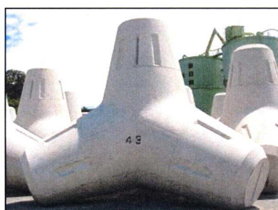
写真-1 溝付消波ブロック
