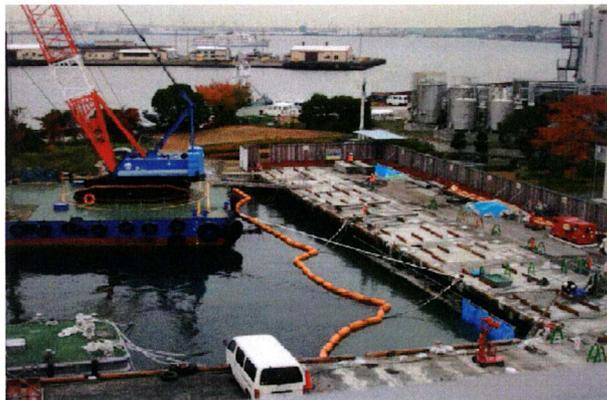
写真-1 造成工事の状況(栈橋の撤去)
