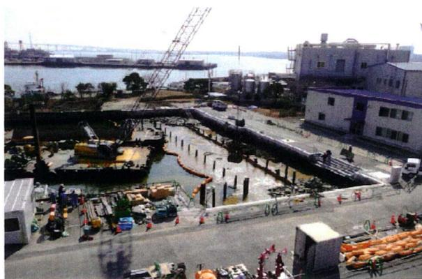
写真-2 造成工事の状況(投石・砂の投入)
