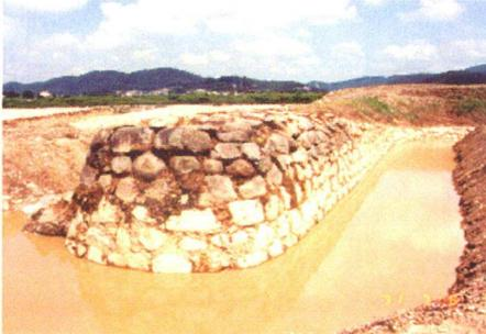
写真-2 二の荒手 (左岸導流堤部)
