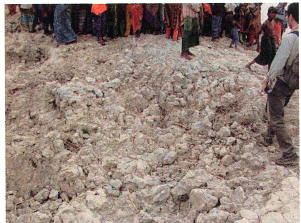
写真-15 ブロック状の侵食面 (地点11)
