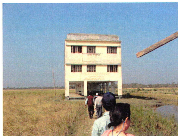
写真-1 サイクロンシェルター
