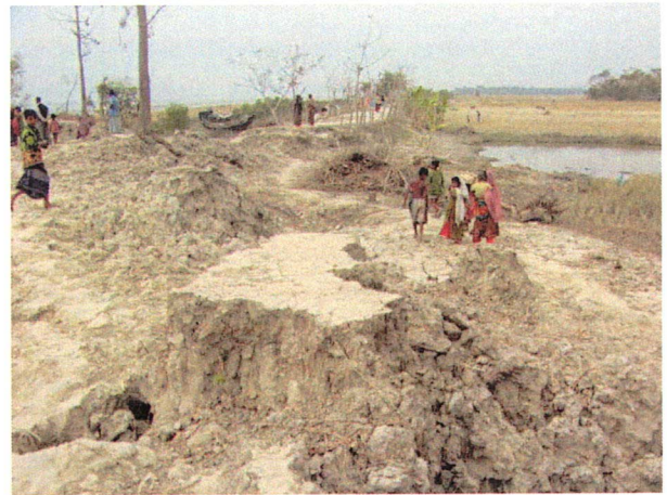
写真-13 越流による堤防の侵食 (地点11) (左: 堤外, 右: 堤内)
