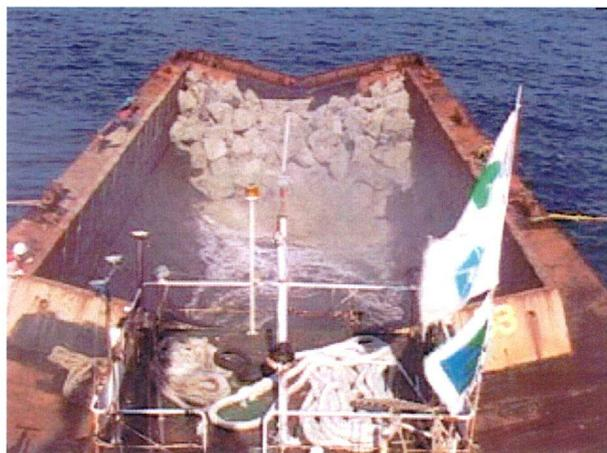
写真-6 現地投入状況(シート工法)
