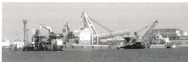
写真-1 施工状況
