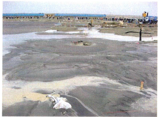
写真-2 液状化発生状況（滑走路端部）
