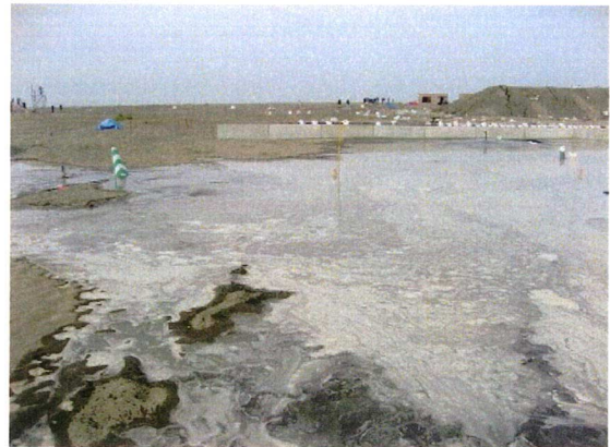
写真-3 液状化発生状況（無舗装平坦部）
