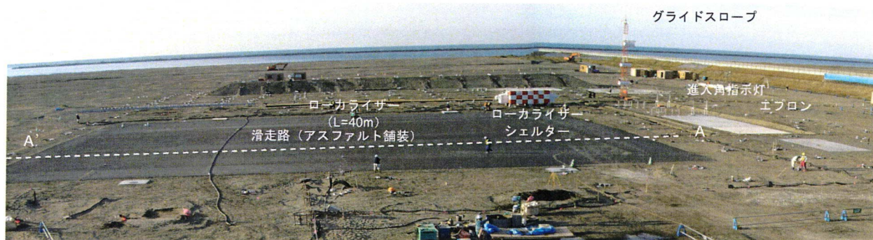
写真-1 現場に設置された主な空港施設
