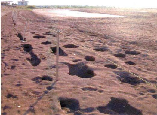
写真-11 緩傾斜護岸先端部にできた陥没孔群
