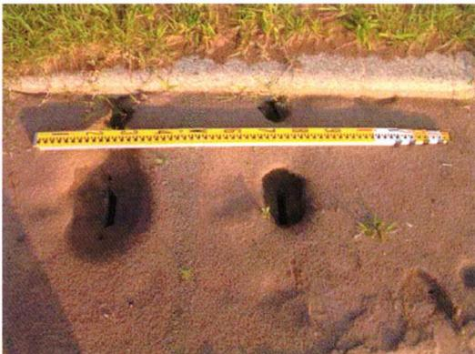
写真-10 側溝における噴砂の跡
