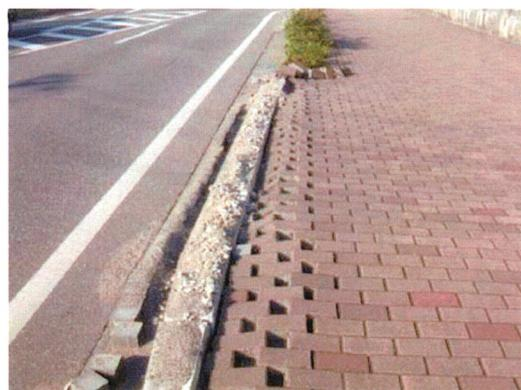
写真-7 インターロッキングブロックの被災
