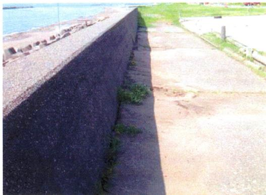
写真-4 護岸の背後の液状化による噴砂
