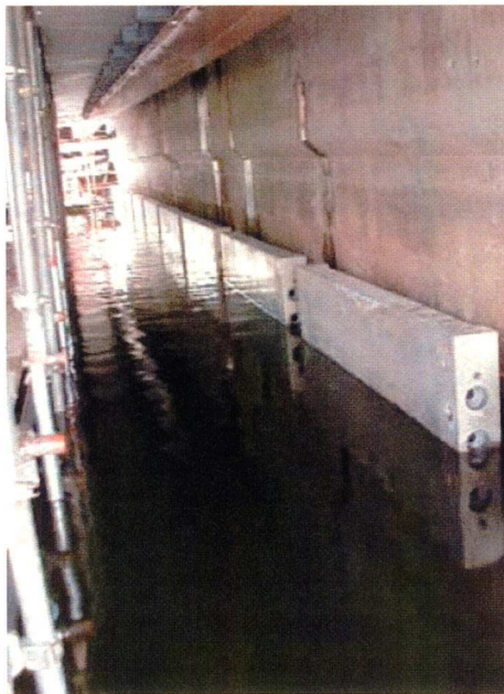
写真-3 PCコンファインドイメージ (締切を行う事なく施工可能) (水域と施工箇所との遮断はされない)
