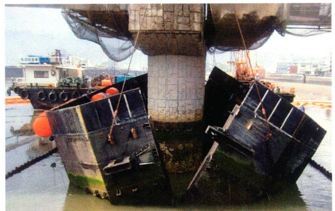
写真-4 鋼製函体を用いた気中補修工法による締切 (鋼製函体設置状況) (河川内と施工箇所が遮断され、周辺環境への影響が少ない)
