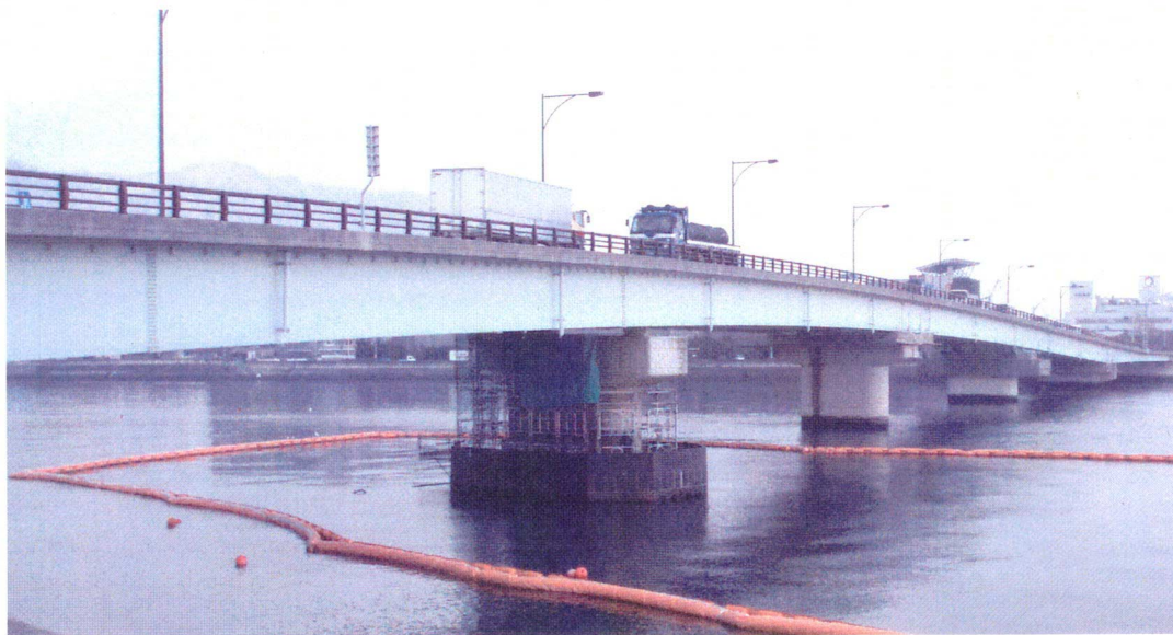
写真-1 鋼製函体を用いた気中補修工法による耐震補強工事の様子
