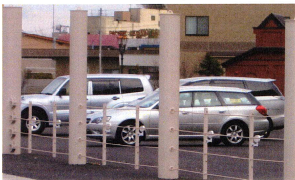
写真-2 津波漂流物対策施設(基本構造)
