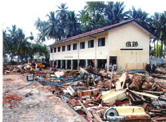
写真-2 スリランカ・カハワの津波後も残った建物
